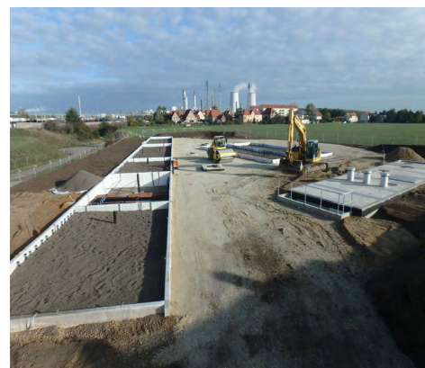
Grundwasserreinigungsanlage CoTra 2 [Bauphase]
