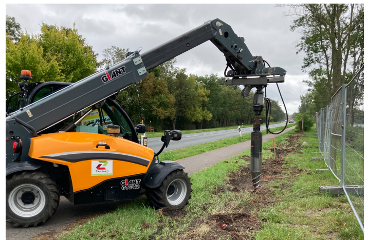
Deponie „Grube Johannes“ | Vorarbeiten für Zaunsetzung
